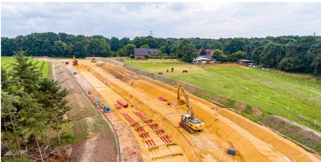
Eine Erdkabelbaustelle in Borken (Münsterland) für ein Wechselstromprojekt. Beim Rhein-Main-Link ist geplant, drei Kabel pro Graben zu verlegen.
